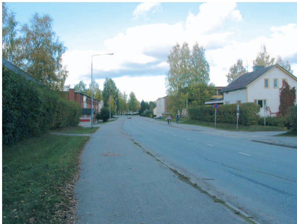
Kuva 1. Otto Mannisen tien linjaus on melko suora pitkältä matkalta, joten nopeusrajoitus 40 km/h ylitetään aivan liian usein. Kohdalle on ehdotettu kavennuksia.
