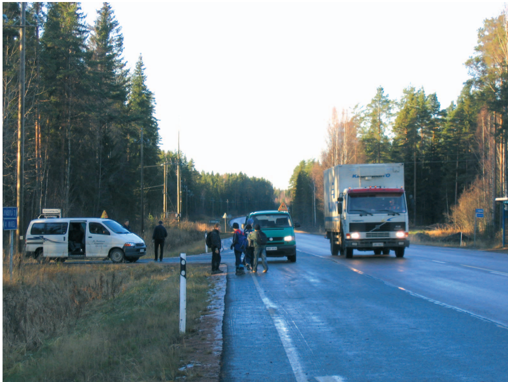
Kuva 7. Vuojalahden koulun edustalla valtatiellä 13:sta on vilkasta, kun oppilaat menevät heitä odottaviin koulutakseihin. Ylileveä liittymäalue johtaa ongelmiin autoilijoiden ja jalankulkijoiden toiminnassa.
