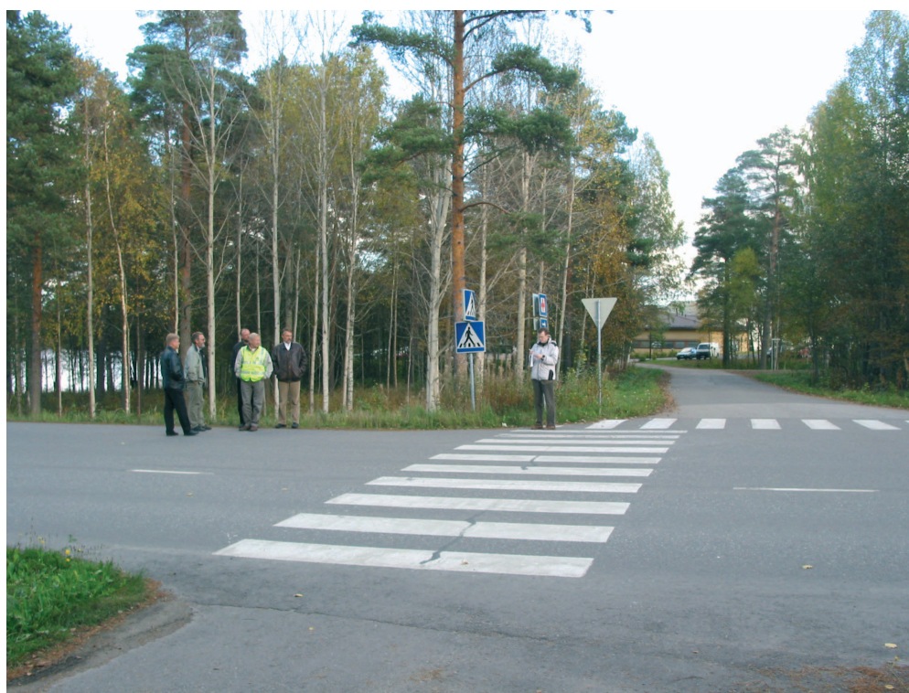
Kuva 6. Liikenneturvallisuustyöryhmä maastokäynnillä tarkastamassa Salme-lantien ylittävää suojatietä, joka on Mäkipentintien liittymäalueella. Parantamistoimenpiteenä on suojatien siirto.
