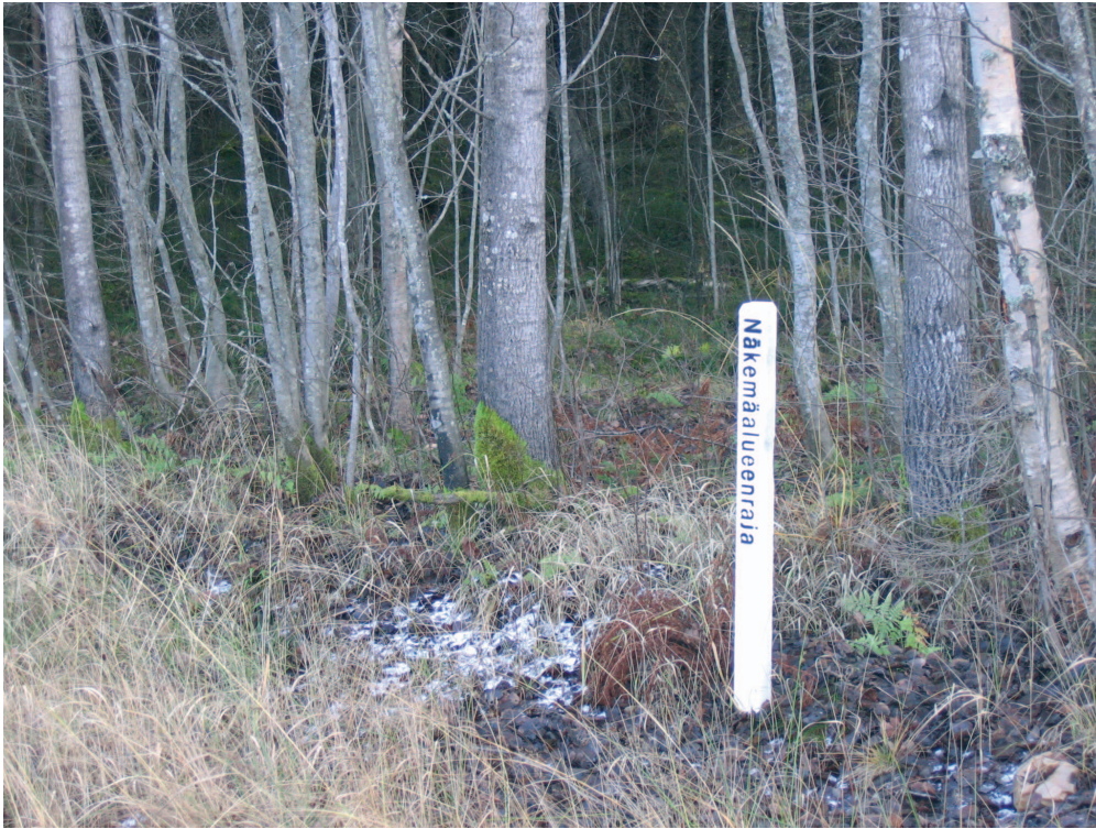
Kuva 8. Näkemäalueen rajatolppa vt 13 Jyväskylätien ja Makkolantien liittymässä.
