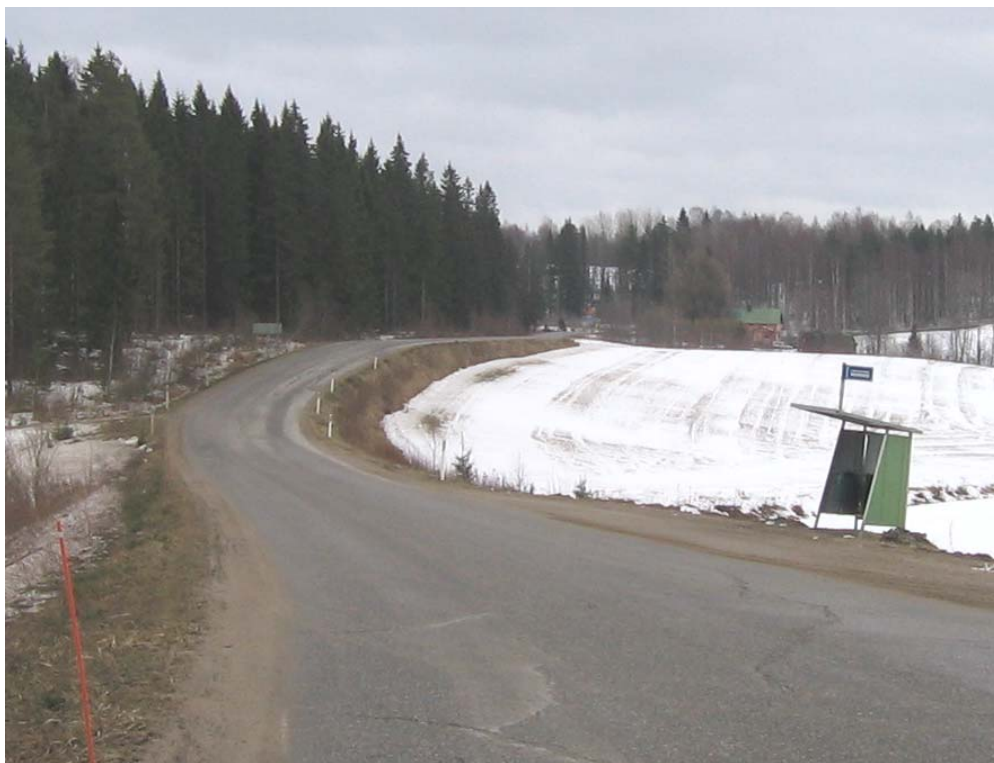
Kuva 30. Maantie 569 Nousionmäen kohdalla (kohdenumero 44).
