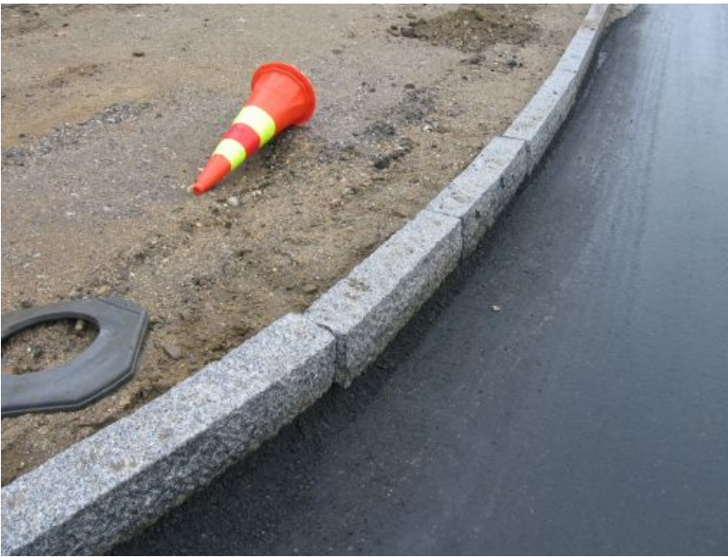
Kuva 3. Keskustan kohdalla ajoradan reunassa on graniittinen reunakivi.
